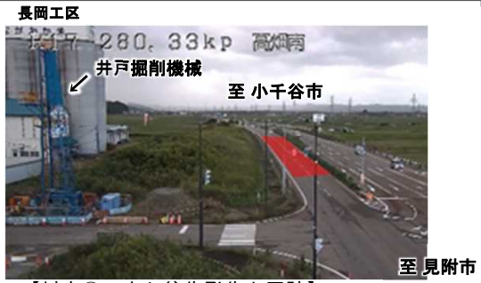
【対応③：立ち往生発生を予防】 R17高畑南交差点前後の上り勾配車線に消雪パイプを設置
