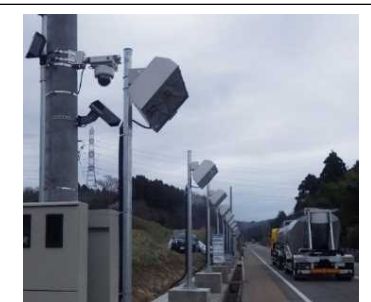
遠赤外線融雪装置(施工イメージ)
