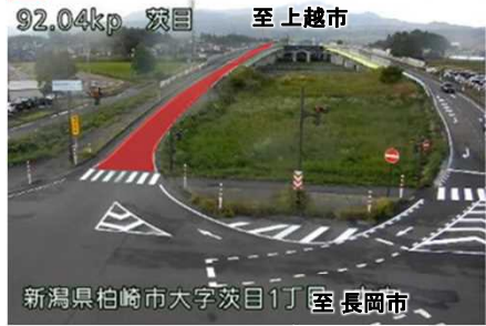
【対応⑤: 除雪効率化】 R 8 柏崎高架橋(下)に消雪パイプ設置
