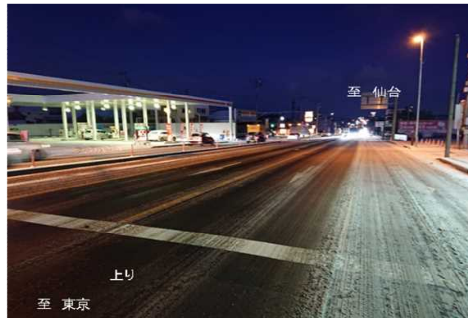
凍結抑制舗装の試行
