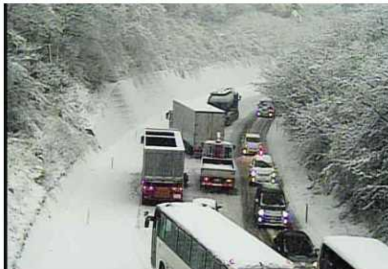
①日時:平成27年1月30日16:00頃 場所:国道6号 福島県いわき市～喜岡町 備考:災害対策基本法に基づく区間指定を実施
