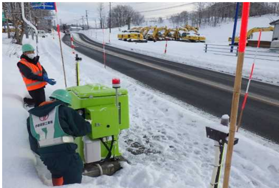
凍結抑制剤自動散布装置の設置
