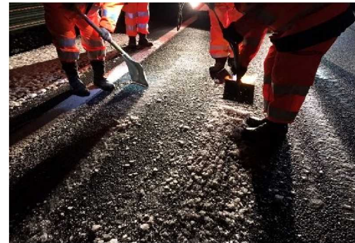
凍結路面部の人力除雪
