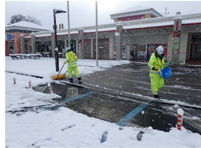
休憩施設園地部の人力除雪
