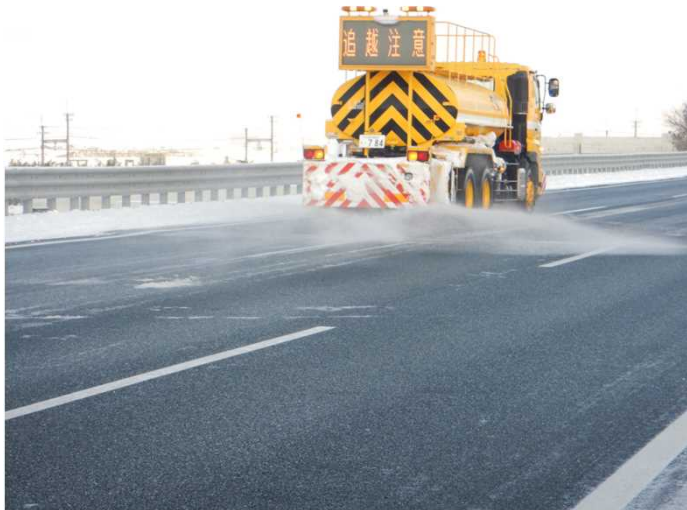
凍結防止剤散布作業
