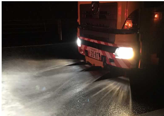
散水車による排雪作業
