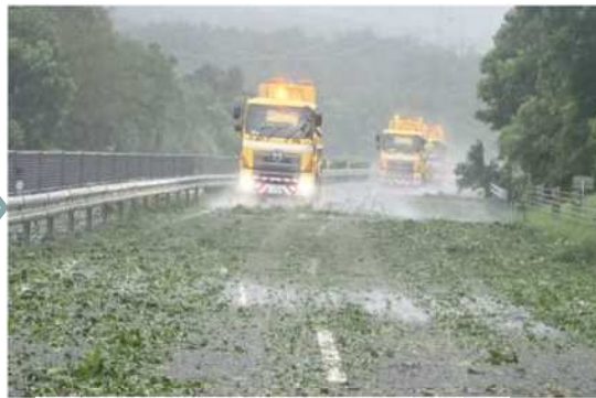
前面散水車による路面清掃
