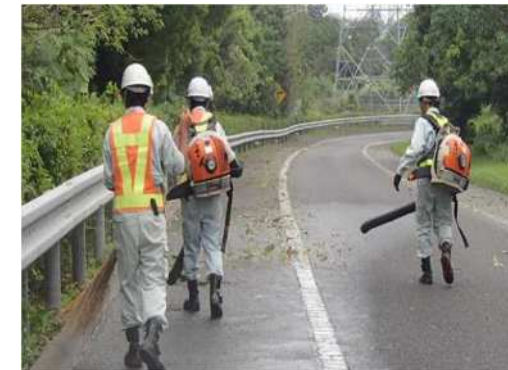
人力によるブローア清掃
