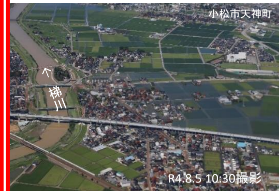
梯川周辺浸水被害状況 (石川県小松市)
