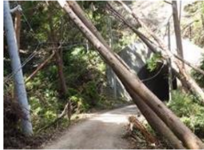
電柱・倒木倒壊の状況 (千葉県鴨川市)
