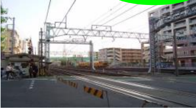
踏切障害事故 《死者2名、負傷者2名》
