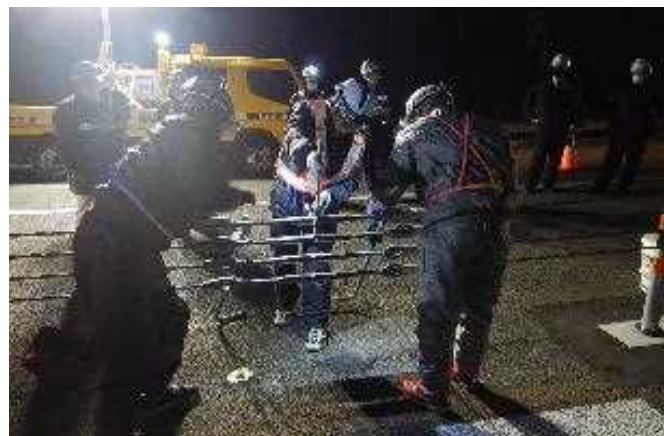
ワイヤロープ式防護柵の撤去状況（訓練）
