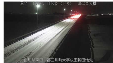
④通行止めによる滞留の状況 （1月4日 20:00頃）
