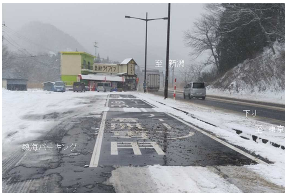
チェーン着脱場の融雪設備整備
