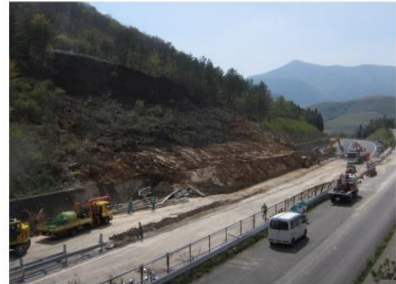
平成28年4月19日11時 応急復旧作業状況
