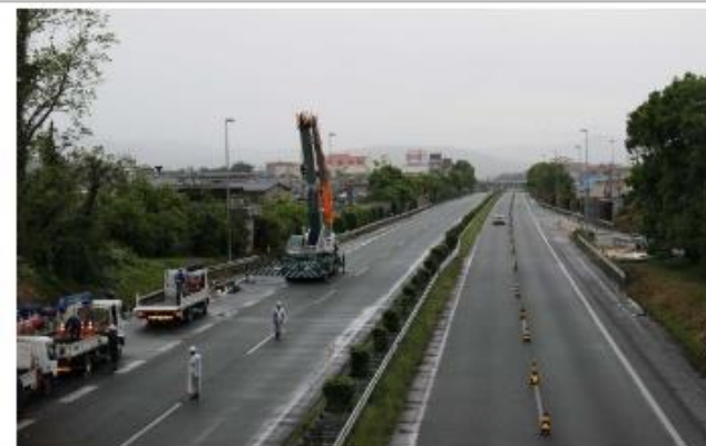
平成28年4月27日10時 撤去作業状況
