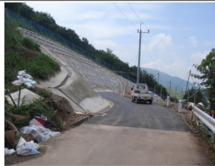
平成28年 8月 5日 本復旧作業状況
