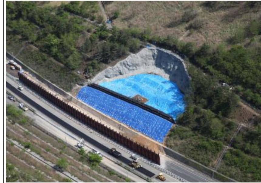
平成28年4月30日15時 応急復旧作業状況
