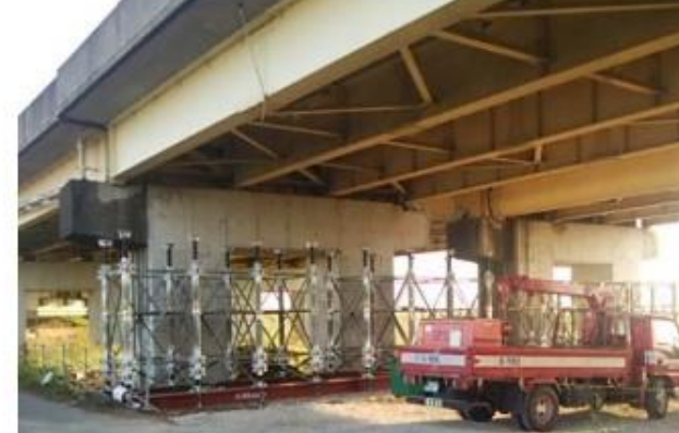
平成28年4月19日16時 応急復旧作業状況
