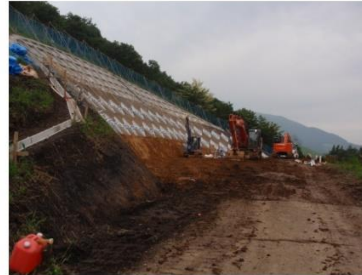
平成28年 7月 1日 本復旧作業状況
