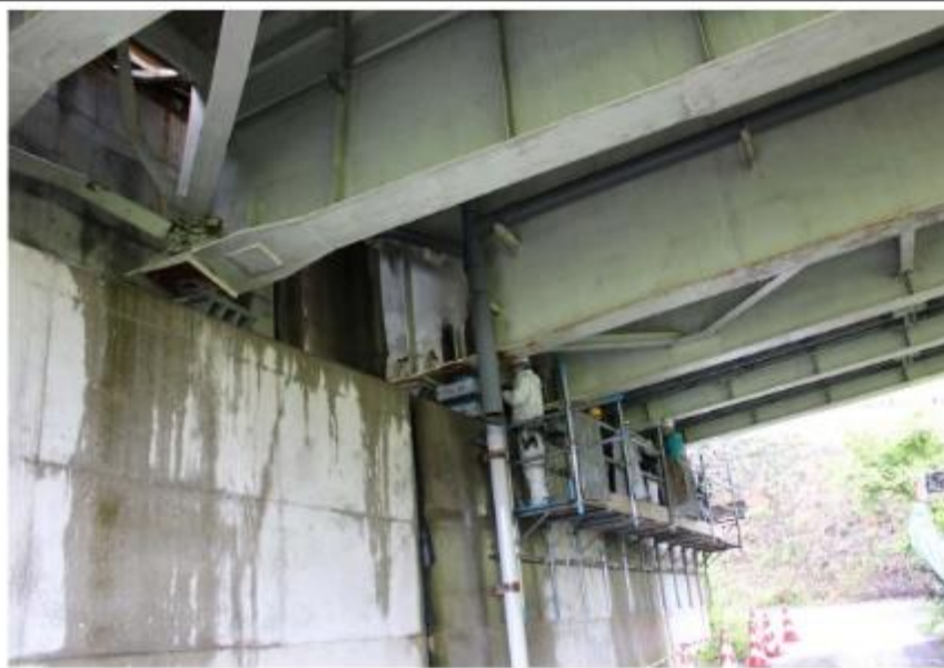
平成28年4月27日15時 応急復旧作業状況
