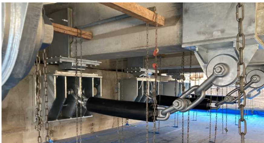
落橋防止装置設置後写真(土器川大橋)
