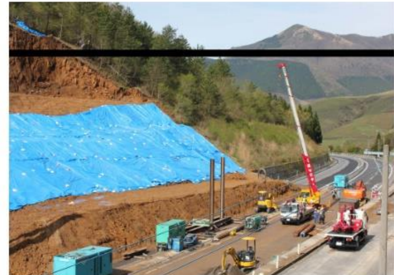
平成28年4月22日9時 応急復旧作業状況
