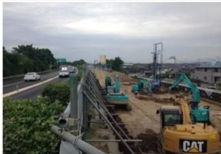
平成28年5月30日 本復旧作業状況（下り）
