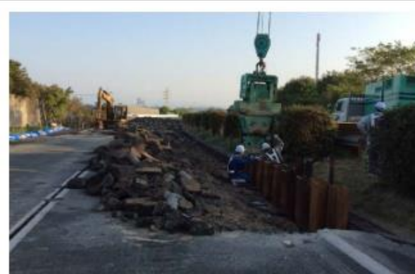
平成28年4月19日17時 応急復旧作業状況
