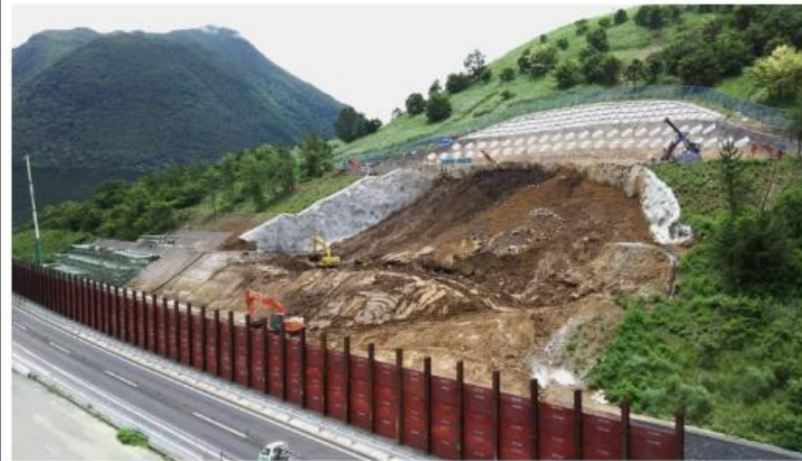
平成28年 7月 1日 本復旧作業状況
