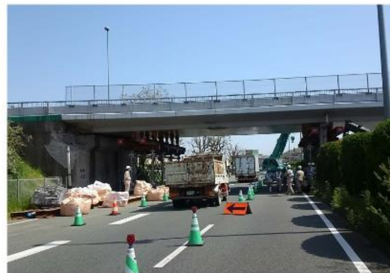
平成28年4月20日10時 応急復旧作業状況
