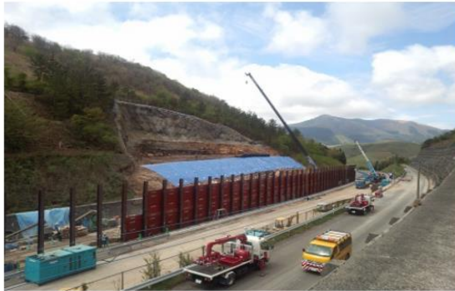
平成28年4月27日14時 応急復旧作業状況
