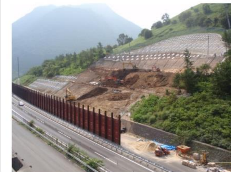
平成28年 8月 5日 本復旧作業状況
