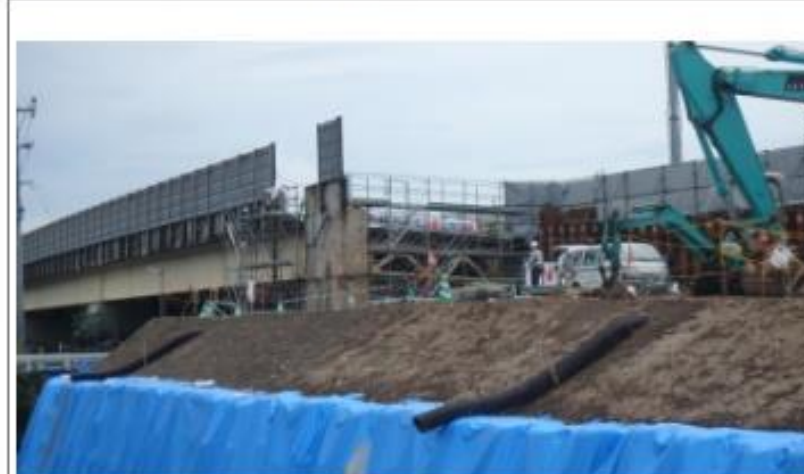
平成28年6月30日 本復旧作業状況（下り）
