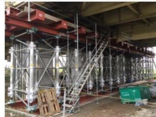
平成28年4月24日10時 応急復旧作業状況
