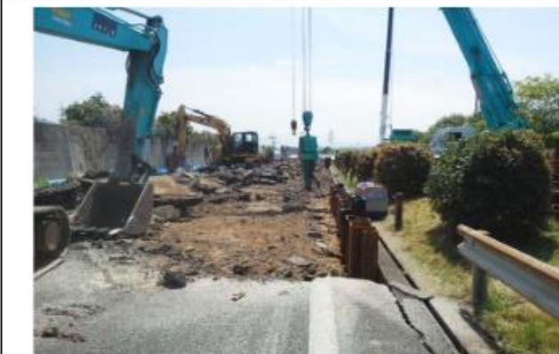
平成28年4月20日13時 応急復旧作業状況
