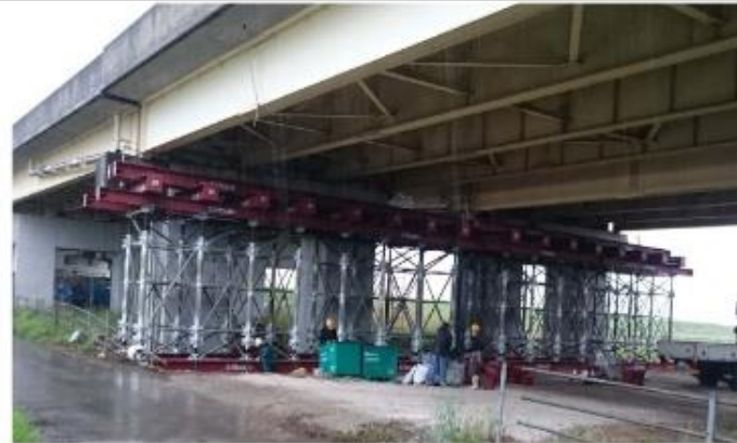
平成28年4月21日9時 応急復旧作業状況
