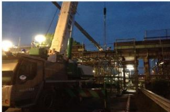
平成28年4月24日5時 撤去作業状況
