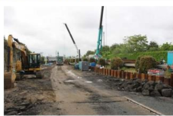
平成28年4月22日8時 応急復旧作業状況
