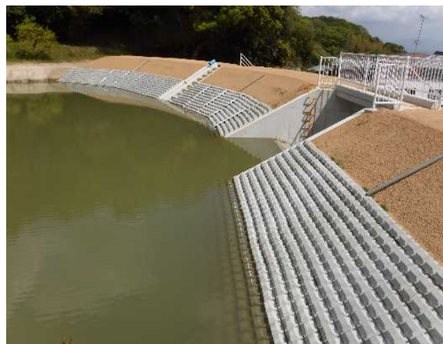
改修後のため池
