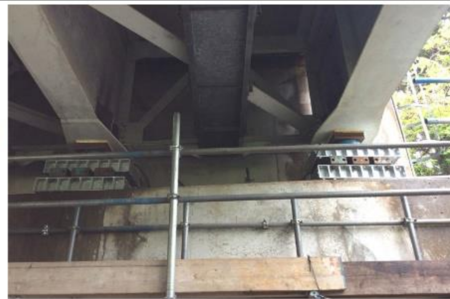
平成28年4月28日12時 応急復旧作業状況
