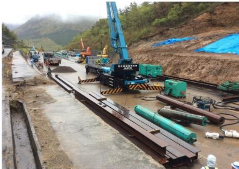
平成28年4月21日15時 応急復旧作業状況
