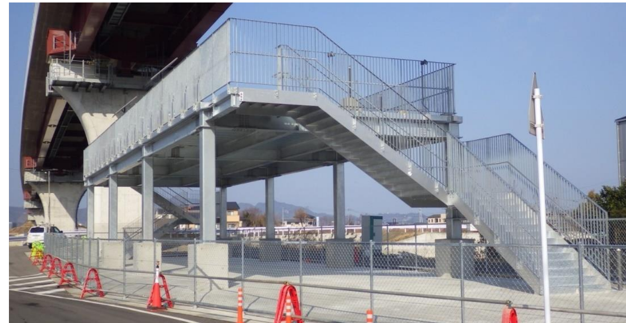
徳島自動車道 松茂PA～徳島JCT間(北島町)
