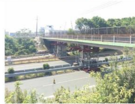
平成28年4月19日13時 応急復旧作業完了
