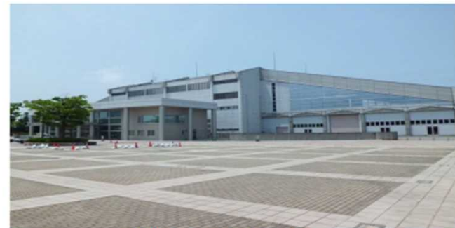
産業展示館4号館 外観
