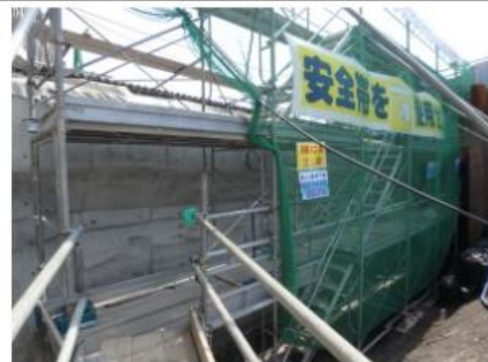
※損傷した橋台の補修
