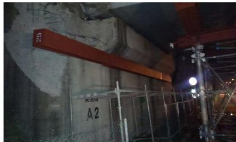
平成28年4月20日21時 応急復旧作業状況
