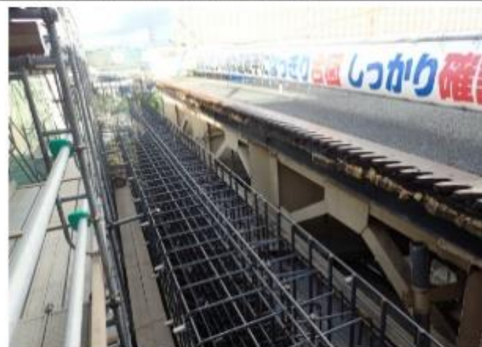
※損傷した橋台の補修
