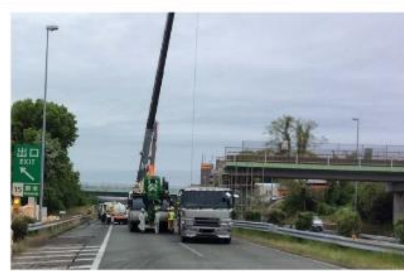
平成28年4月25日10時 撤去作業状況
