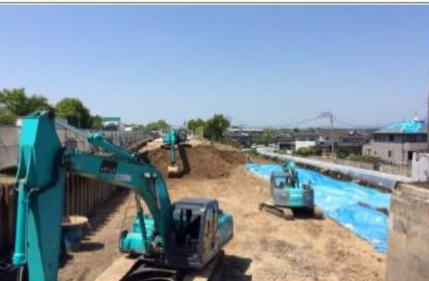
平成28年4月30日17時 本復旧作業状況 (下り)
