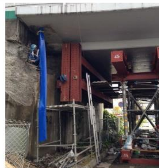
平成28年4月22日9時 応急復旧作業状況
