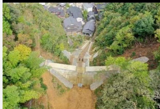
土砂災害対策 上陰東谷川砂防堰堤
