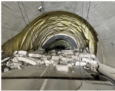
国道249号大谷トンネル（珠洲市）
