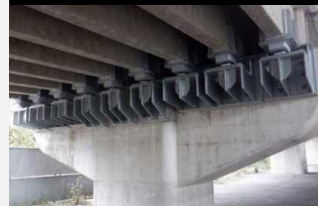
道路防災対策 夙川橋 橋梁耐震補強
