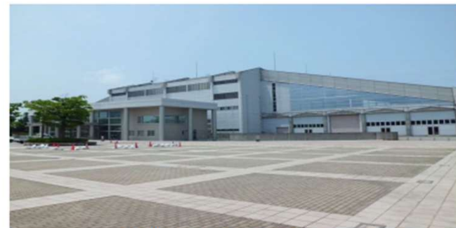
産業展示館4号館 外観
