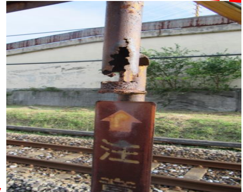
ミラーの骨組みは経年劣化で 折れる寸前
