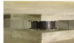
地震による振動エネルギー（揺れ）を免震装置が吸収することで、建物自体の被害を抑制
