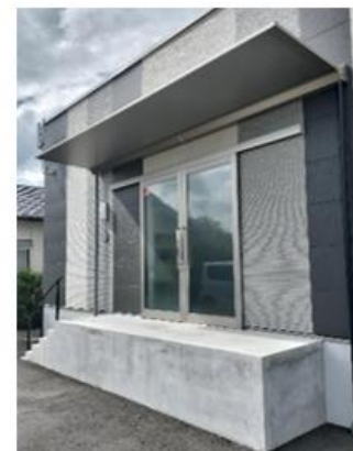
トラック搬入口 荷台と事務所床面がほぼ同じ高さになり、搬入しやすくなった
