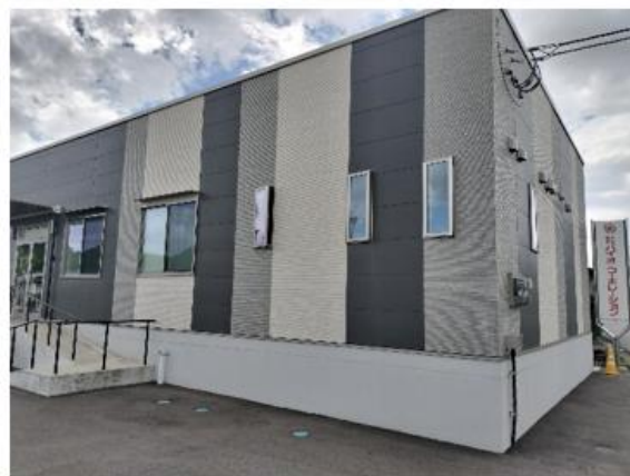
事務所外観 建物基礎を1mかさ上げしている
