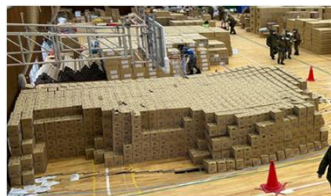
床が抜け落ちた体育館
