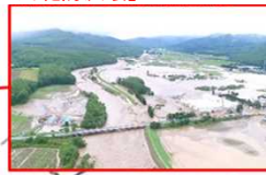
H28.8.30～31【台風】空知川（南富良野町） 降雨量：H28.8 72h 18地点【記録更新】 【空知川堤防決壊】
