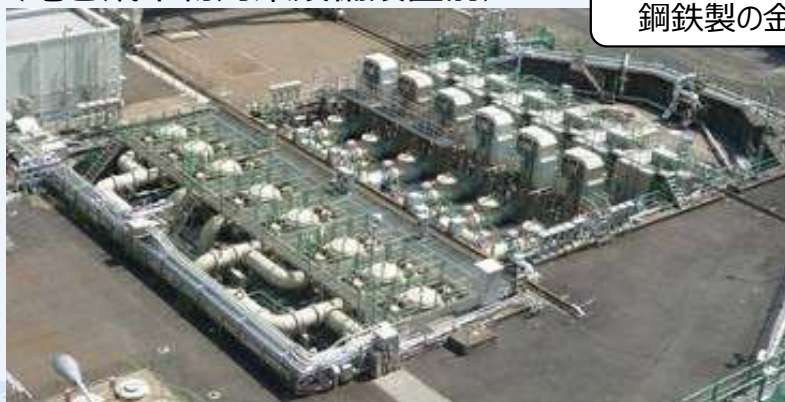
〔竜巻飛来物対策設備設置前〕
