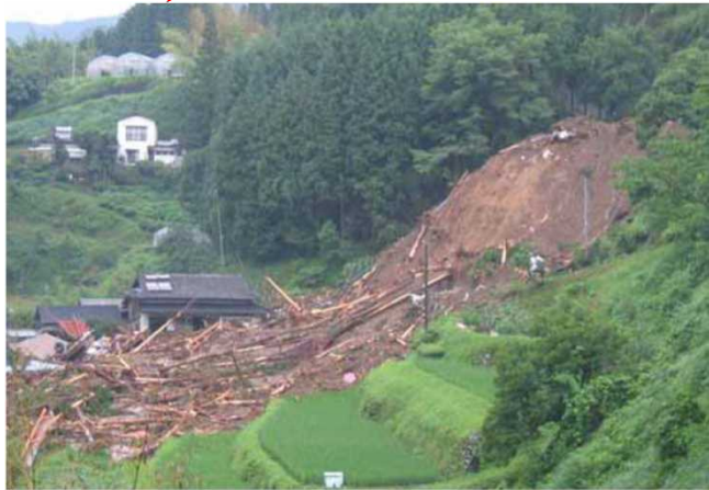
土石流 がけ崩れ
