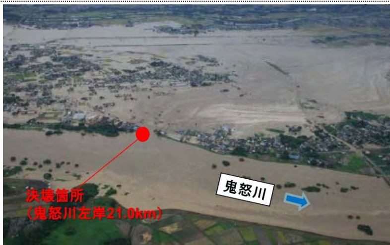
上空から撮影した決壊地点(常総市三坂町)の様子
