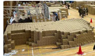
床が抜け落ちた体育館
