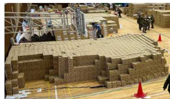
床が抜け落ちた体育館
