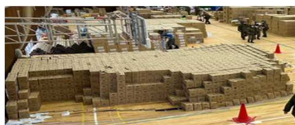
床が抜け落ちた体育館
