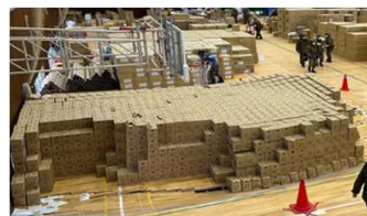
床が抜け落ちた体育館
