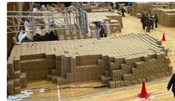
床が抜け落ちた体育館
