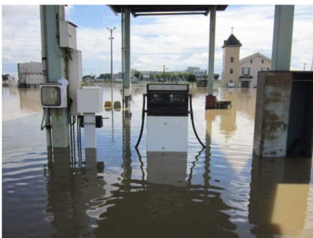
水没した給水スタンド(車両基地内)
