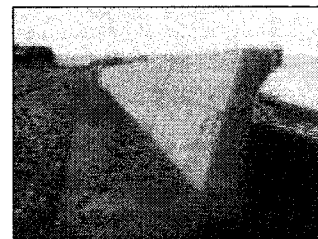
【護岸壁の一例】
