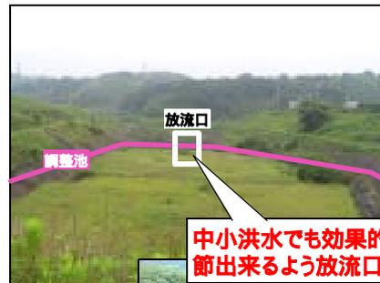
中小洪水でも効果的に洪水調節出来るよう放流口を改良
