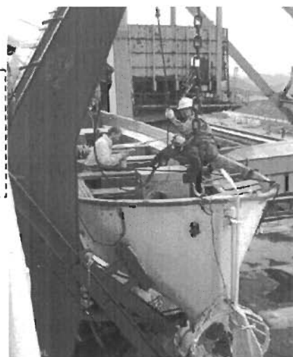
PSCの現場(救命艇の確認)
