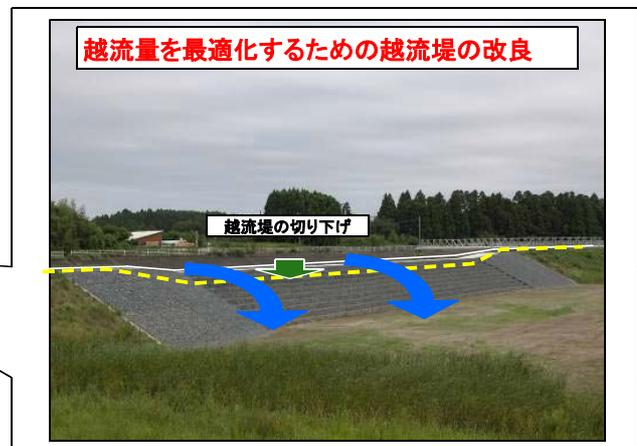
河川改修が進捗し、洪水時の水位が低下し、既設の遊水地等の洪水調節機能が低下
