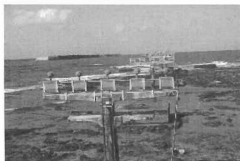
航空保安施設の更新・改良
