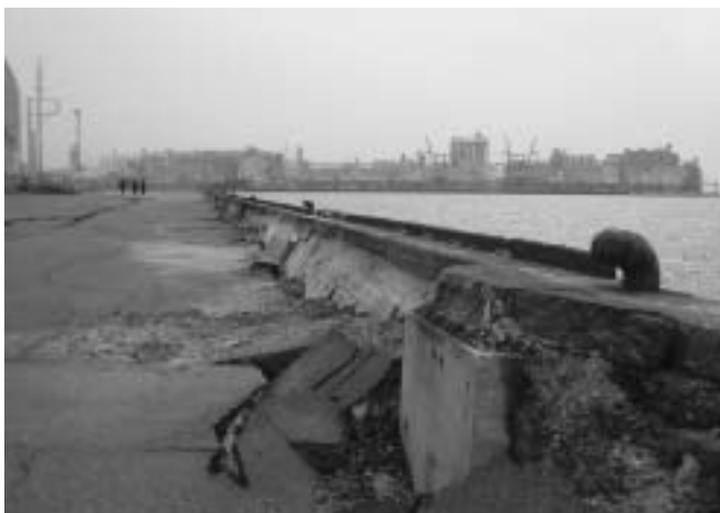
●鹿児島県東之浜港防波堤の被災(台風14号)
