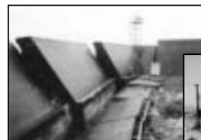
地震による堤防の被災状況
