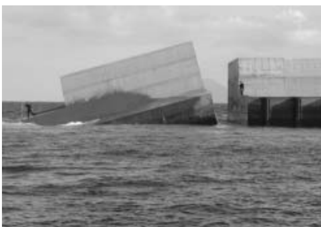
●鹿児島県東之浜港防波堤の被災(台風14号)
