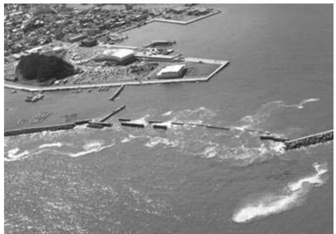
●大分県国東港防波堤の被災(台風14号)
