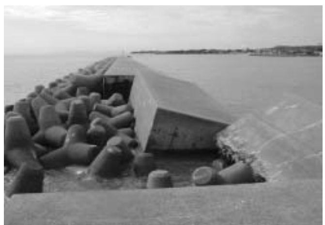
●大分県国東港防波堤の被災(台風14号)
