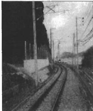
【落石防止擁壁の一例】
