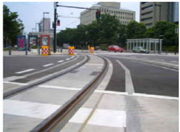
制振軌道の整備
