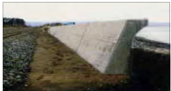
【護岸壁の一例】
