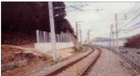
【落石防止擁壁の一例】
