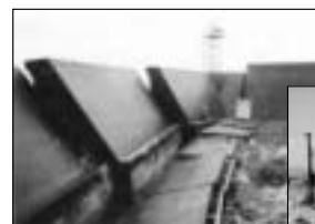
地震による堤防の被災状況
