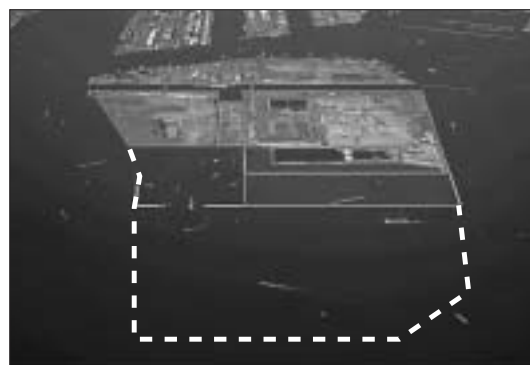
【東京港 海面処分場】
