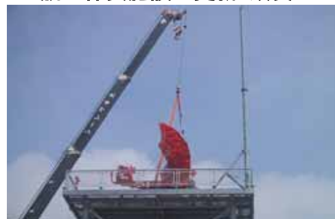
【老朽化したレーダーの交換】
