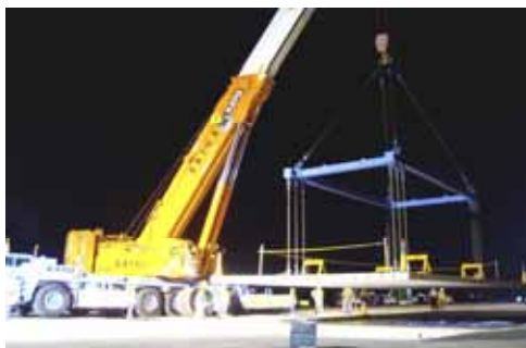
【破損したPC版の取替え】
