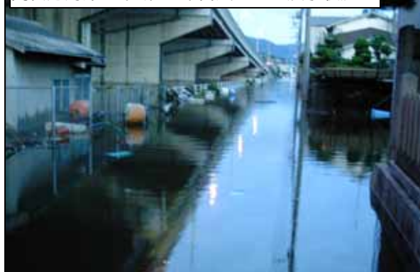
高松港海岸 平成16年台風による浸水状況
