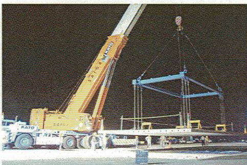
【破損したPC版の取替え】
