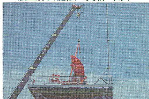
【老朽化したレーダーの交換】
