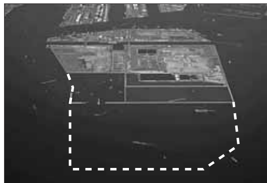
【東京港 海面処分場】
