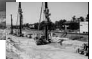
耐震補強 (液状化対策) (三重県 津松阪港)
