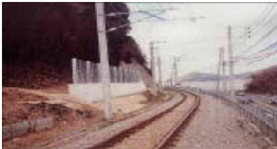
【落石防止擁壁の一例】
