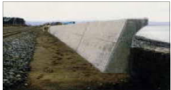
【護岸壁の一例】
