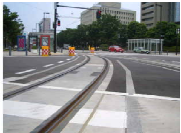
制振軌道の整備
