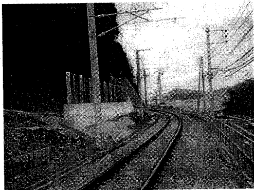
【落石防止擁壁の一例】
