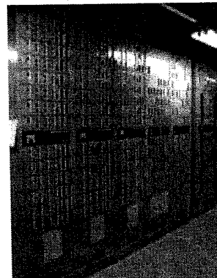
【自動列車制御装置】
