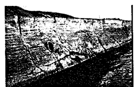
堤防の表法被覆工 が損傷
