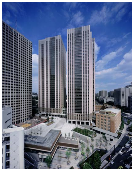
【中央合同庁舎第 7 号館】
