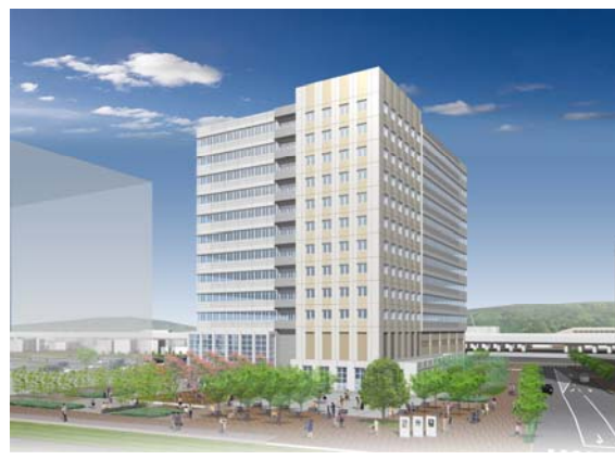
【熊本中心市街地活性化基本計画区域】 熊本地方合同庁舎 (平成 24 年度完成予定)
