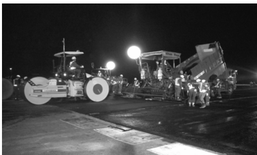
【滑走路の舗装改良】
