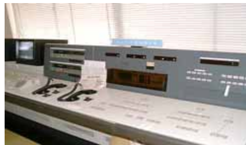
<ダム管理用制御処理設備>
