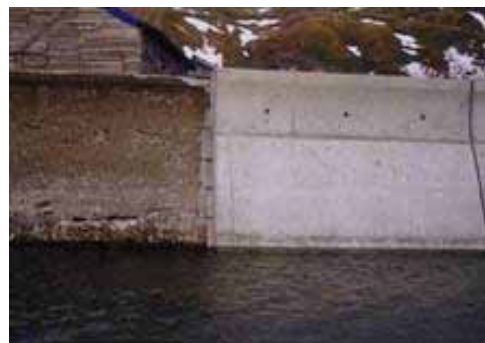
老朽化対策による改良例
