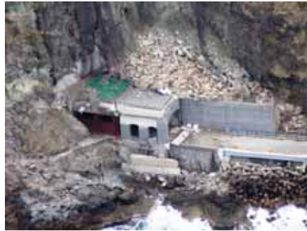
国道249号（石川県輪島市町野町 曾々木八世乃洞門）
