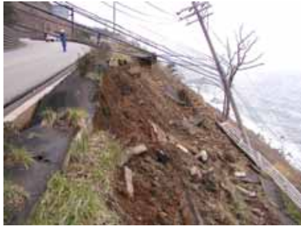
国道249号（石川県輪島市深見町）
