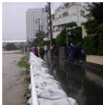
水防活動状況 (多摩川、東京都世田谷区二子玉川)
