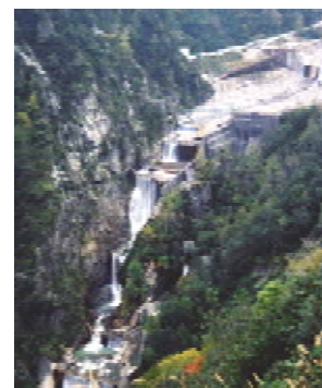
地域を守る歴史的砂防えん堤 (富山県 白岩砂防えん堤)
