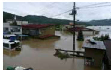
家屋の浸水状況 (秋田県能代市二ツ井)
