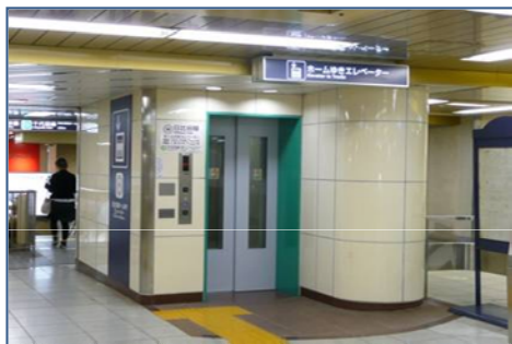
《エレベーター》
