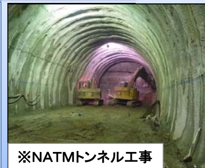
亀岡トンネル工区
