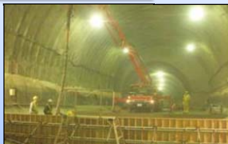
※トンネル工事(コンクリート打設)
