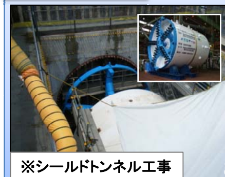
荒井トンネル工区
