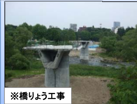
広瀬川橋りょう外工区
