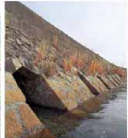
三重県四日市市 四日市港北突堤上部防波堤
