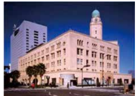
横浜税関本関(1934建築、2003改修) Yokohama Customs
