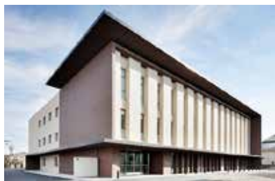
▲ 環境負荷低減に配慮した官庁施設の一例 (神戸地方・家庭裁判所明石支部) Example of "Environmentally-friendly Government Buildings"
