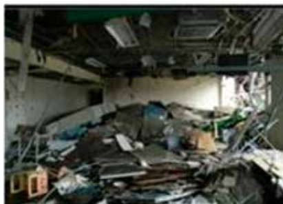
▲ 東日本大震災における津波による被害 Situation Regarding Damage to Government Buildings and Facilities
