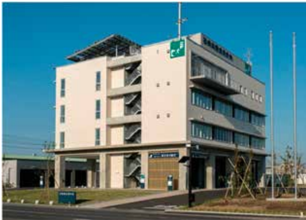
▲ 津波発生時の災害応急対策活動と津波避難ビルの機能を確保した石巻港湾合同庁舎 Ishinomaki Government Building
