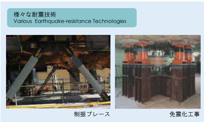
▲ 免震レトロフィットにより災害応急対策活動拠点としての機能強化を図った中央合同庁舎第3号館 Central Government Building No.3
