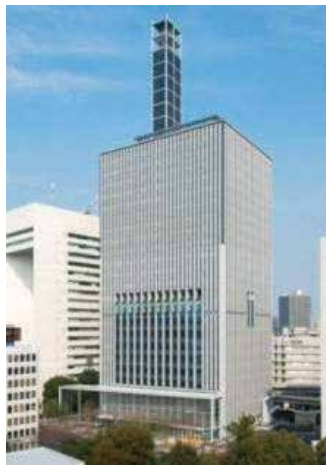
▲ 九段第3合同庁舎 Kudan Government Building No.3
