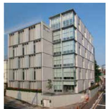
▲ BIMプロジェクトの例 (新宿労働総合庁舎) Shinjuku Government Building for Ministry of Labor
