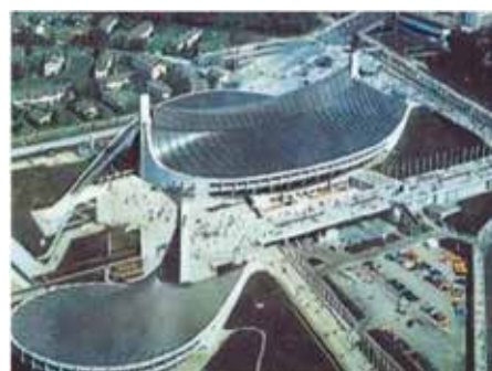
国立屋内総合競技場 (1964) National Indoor Stadium
