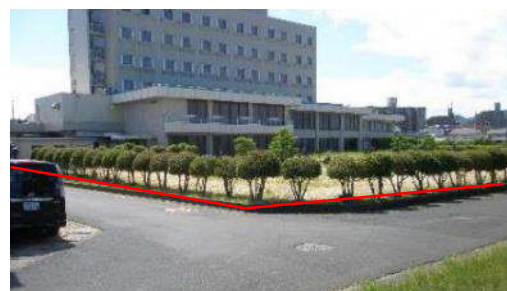
④敷地北側から
