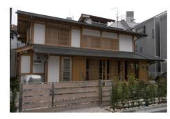
写真 3-3 土塗壁を用いない外壁両面真壁 (外部)
