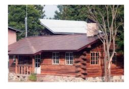
写真 3-5 丸太組構法 外部両面丸太現し (外部)
