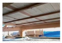
写真 3-8 断熱材が露出しないような 対策を講じた開放的な床下
