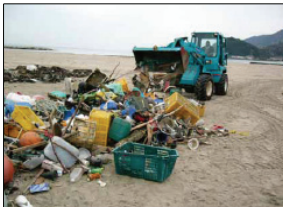
和田海岸のゴミ収集運搬状況
