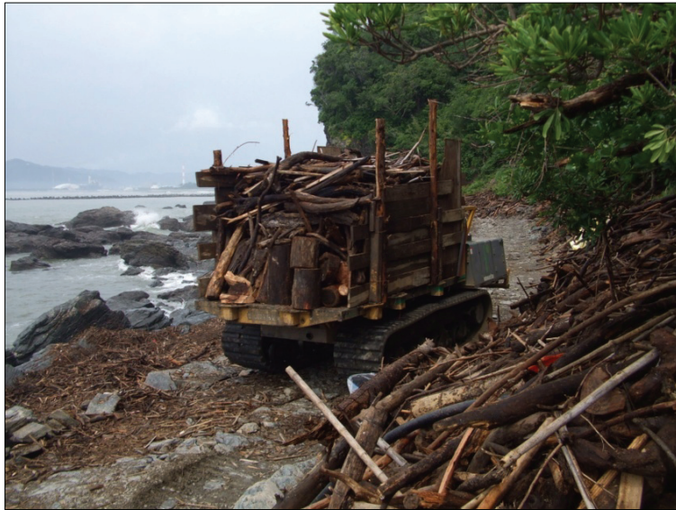
仮設道路を使った流木の運搬状況
