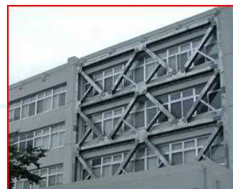
耐震改修 (例:鉄骨による補強)
