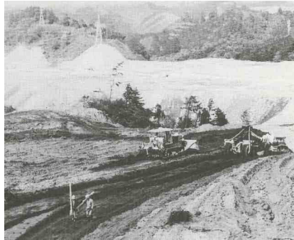
大規模開発(宅地造成)の状況
