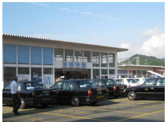
写真 修善寺駅舎（改修前）
