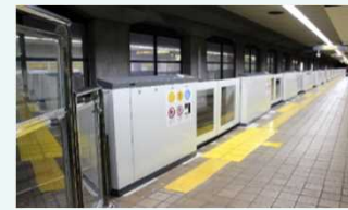
可動式ホーム柵の設置
