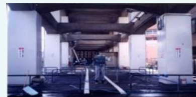
高架橋の耐震対策
