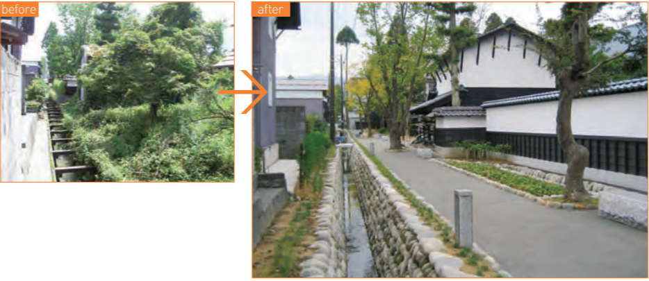
写真2 | 旧内山家周辺地区では、大野城下の特徴である背割り水路を整備。その脇で使われなくなり雑草の茂った小径も整備して人の流れをつくった。用地、物件移転補償、透水性舗装、石積水路の復元等を実施。
