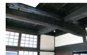
左:写真1 | 大堰公園と金山小学校の境界に沿って通路を整備した。 右:写真3 | 大堰公園の休憩施設には、既存の家を解体した部材が再利用されている。
