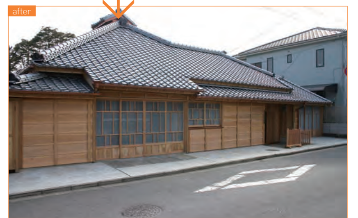
写真6 | 建具の修景、外壁の修理、屋根の葺き替えなどを行った修景事例。
