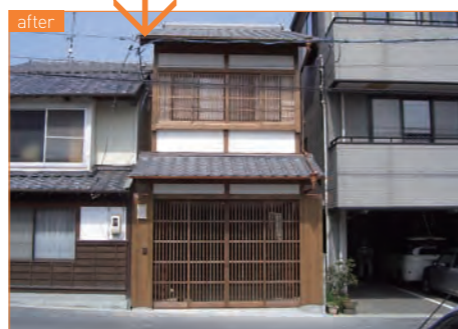
写真3 | 修景基準(マニュアル)に基づいて住宅のカーポート部分に増築を行った事例(1階部分は車庫、2階は居室)。修景の対象は、道路に面した正面部分、横面は道路から3mの範囲まで、屋根は道路に面した側とマニュアルで定められている。
