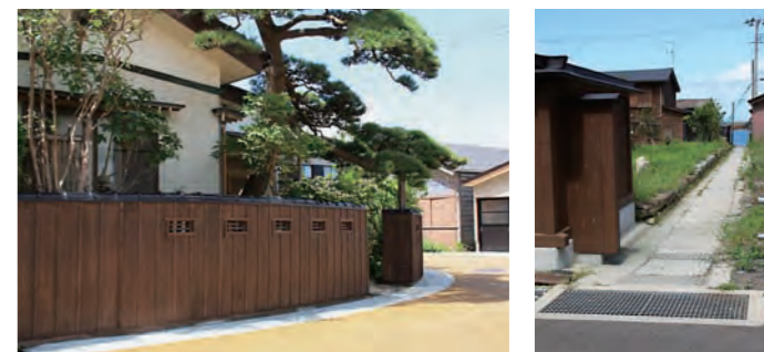
写真2 | 街なみに調和するように、既存のコンクリートブロックの上に木材を貼りつけ、修景整備を行った塀。 写真3 | 水害の後、住民との協議によって整備された下排水施設。
