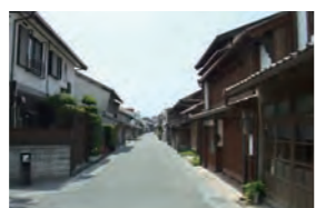
写真2 | 道路美装化、電線類地中化が実施された浜崎本町筋。左端に位置する案内板も新たに設置した。また、手前左の住宅の修景整備を行った。
