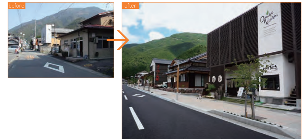
写真2 | 国道440号沿いの道路拡幅に伴う修景整備。道路拡幅に伴う豊かな歩行者空間の創出と、電線類の地中化および地場材を活用した街なみ景観の整備による、中心地のにぎわい再生を図っている。
