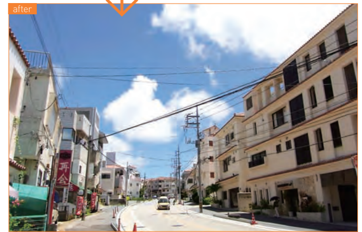
写真3 | 龍潭通り沿線地区。屋根と軒・庇に赤瓦が使用され、街なみ景観のアクセントとなっている。
