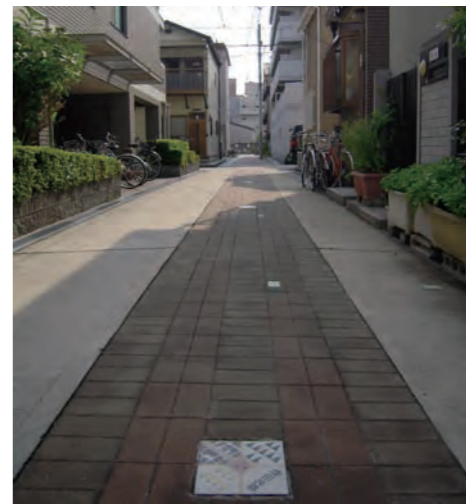
写真4 | 細街路整備では、道路中心線の確定を行い、通りごとにオリジナルのプレート設置した上で道路の美装化を行っている。
