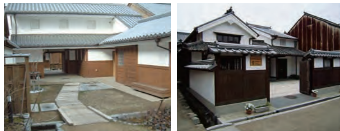
写真2 | 地区内の空地を活かして建設した旧北町生活広場[左]と旧西町生活広場[右]。敷地内には耐震性防火水槽や町家形態の建物を建築し、住民向けの初期消火設備の格納庫とした。
