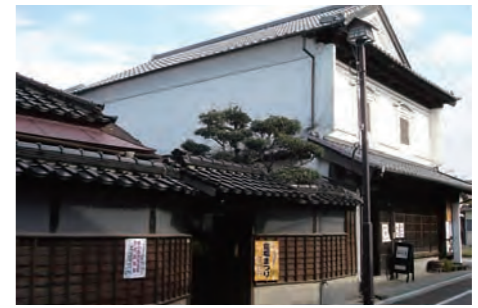
写真1 門前町の雰囲気が感じられるデザインとした街灯。奥に見える土蔵造りの住宅は助成を受けて修景を実施。
