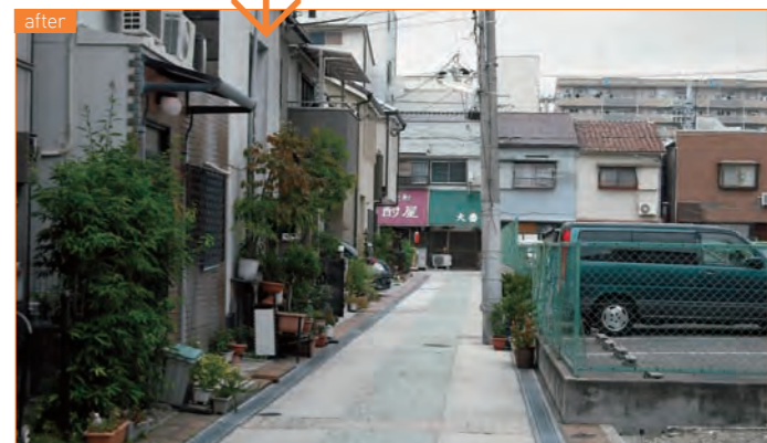
写真2 | 細街路整備が行われた「きんぼうじゅ通り」。道路の拡幅、地下埋設物の整備、道路中心プレートの設置、道路の美装化と道路境界部への側溝整備を実施。また、各敷地の建物セットバック部分50cmの空間は、道路舗装とは別仕様の舗装を行った。
