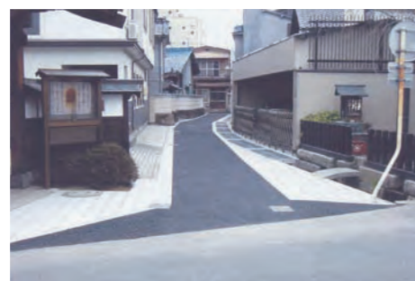
左:写真1 | お城東地区。うら町の道路整備を実施。 右:写真2 | 中央東地区。源智(げんち)の井戸周辺の道路の美化化を実施。
